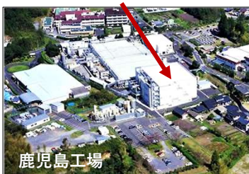
新クリーンルーム棟
