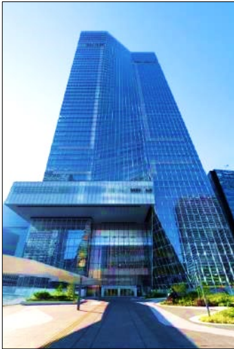
虎ノ門ヒルズステーションタワー 20、21階 虎ノ門二丁目6番1号
